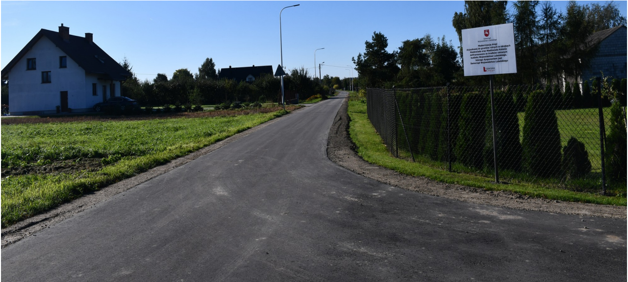
Droga po remoncie w Niedźwiadzie
