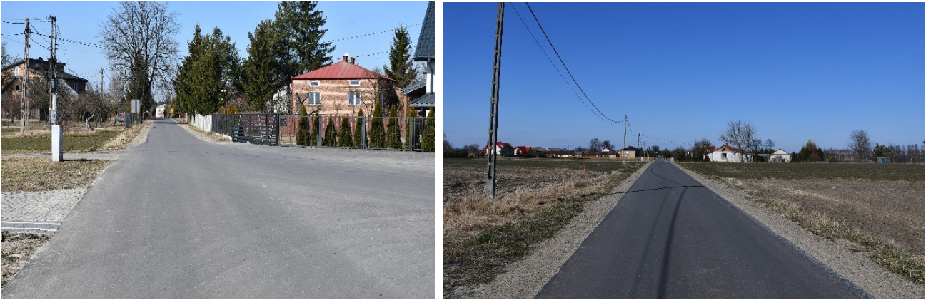
Wýremontowane drogi w Brzeźnicy Leśnej
