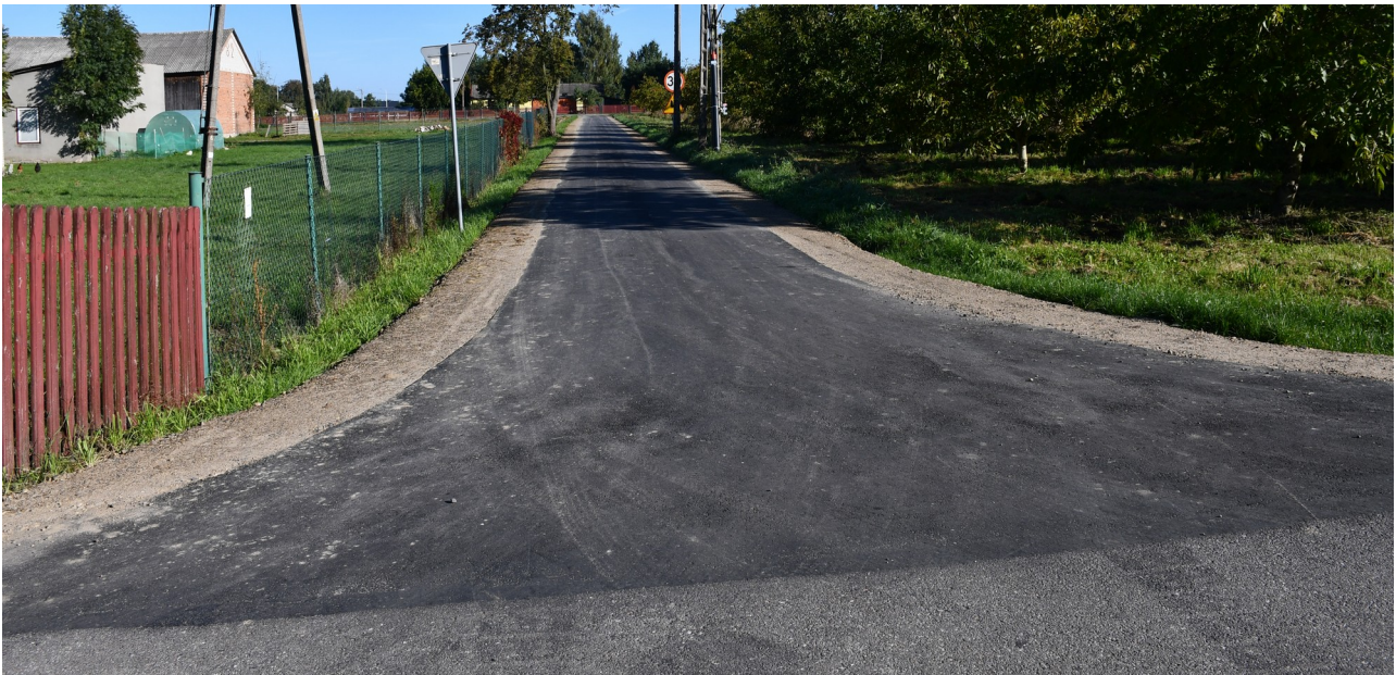
Droga po remoncie w Niedźwiadzie-Kolonii
