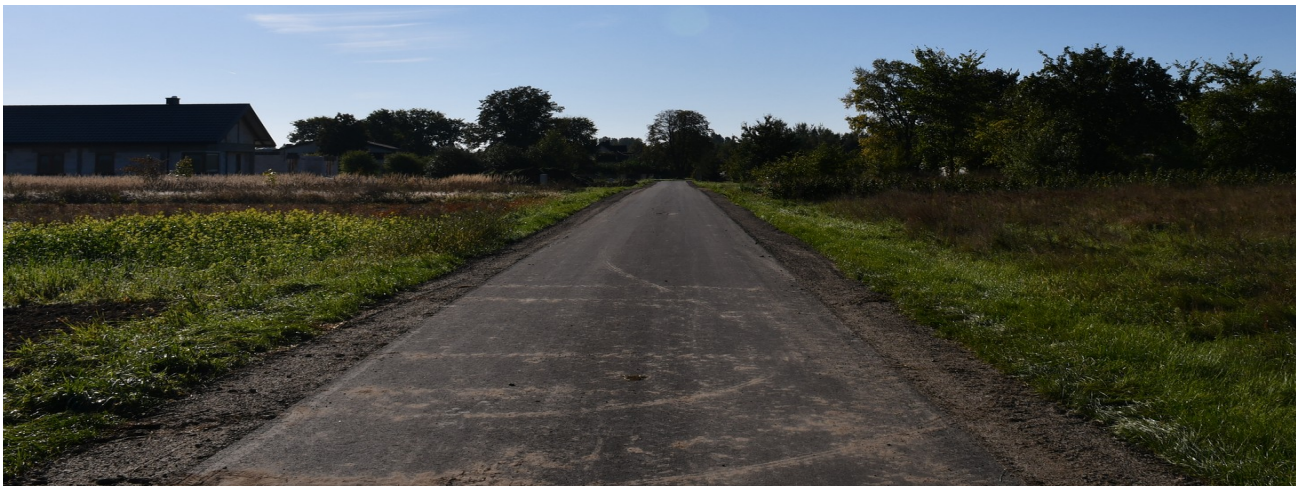
Wýremontowany odcinek drogi w Brzeźnicy Książęcej
